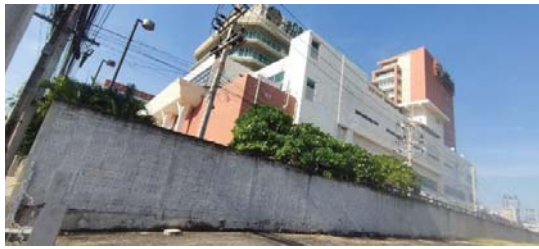
รูปที่ 2-7 รั้วของโครงการสามารถป้องกันการพังทลายของดินถมสู่พื้นที่ข้างเคียงได้
