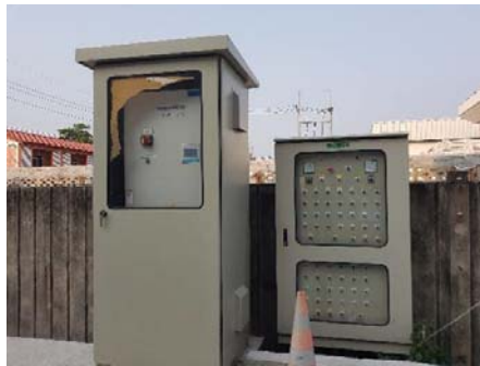
รูปที่ 2-18 การติดตั้งมาตรวัดไฟฟ้าของระบบบำบัดน้ำเสีย
