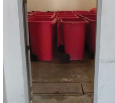
รูปที่ 2-11 รางรวบรวมน้ำเสียจากห้องพักรวมผลอยเข้าสู่ระบบบำบัดน้ำเสีย
