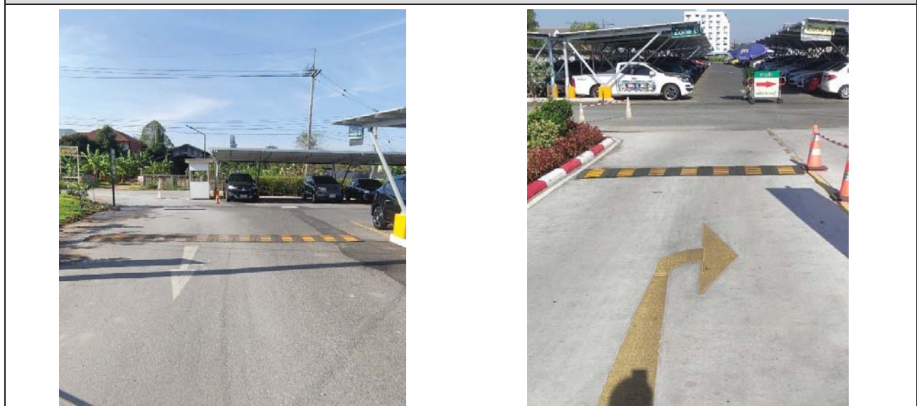
รูปที่ 2-2 สันนุนชะลอความเร็วรถบริเวณทางเข้า-ออก โครงการและภายในโครงการ
